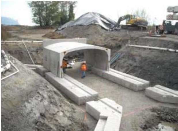
Precast Foundation with closure pour
